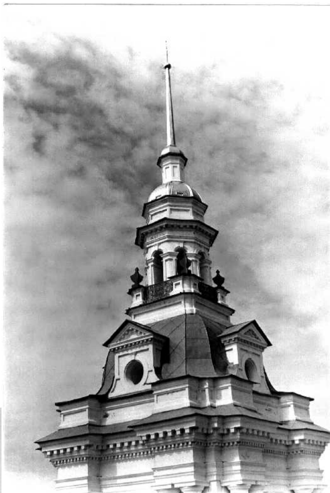
Колокольня ц.Спаса в рядах после восстановления. Завершение.
