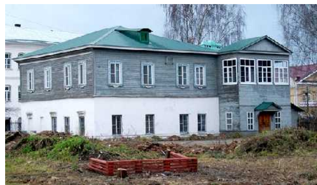
Православный духовно-культурный центр г. Галича (надстроенное здание бывшей богадельни при Богоявленской церкви). Вид из церковного двора. Фрагмент фото Н. В. Сотникова. 1.11.2013 г.
