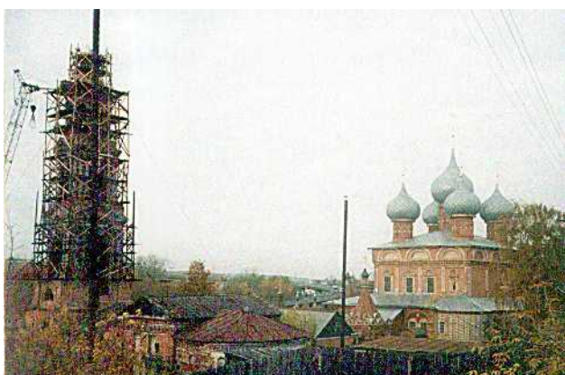
Колокольня Знаменской церкви в процессе реставрации. Фото конца 1990-х гг.
