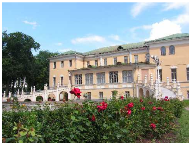
Усадьба губернатора (дворовый фасад). Фото 2000-х гг.
