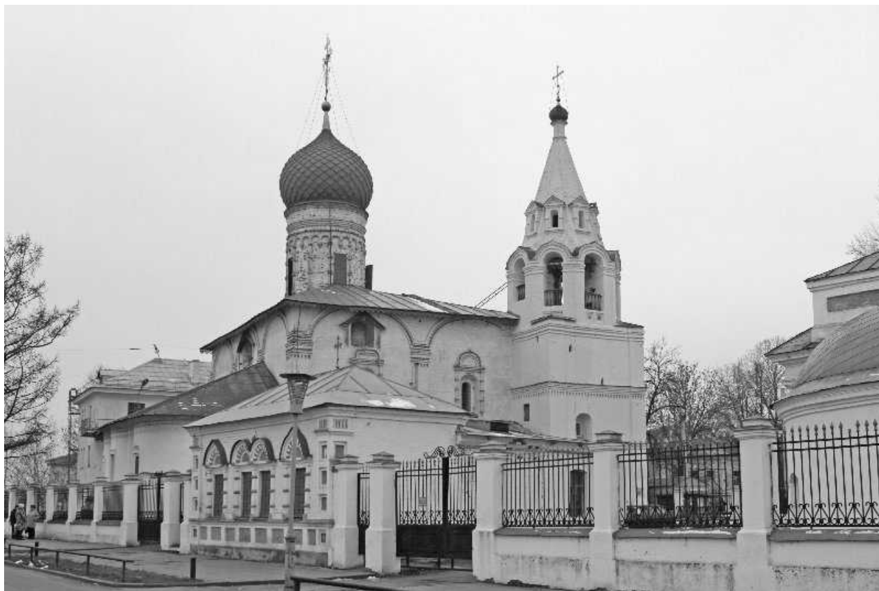
Церковь Дмитрия Солунского в Ярославле, проект реставрации которой разработал Л. С. Васильев. Фото 2000-х гг. (Выходящая на тротуар четырьмя окнами сторожка в 1995 г. перестроена по инициативе священника прихода, что, по мнению реставраторов, «не только исказило первоначальный облик и пропорции сооружения, но и нарушило существовавшее равновесие масс в системе всего архитектурного ансамбля».)
