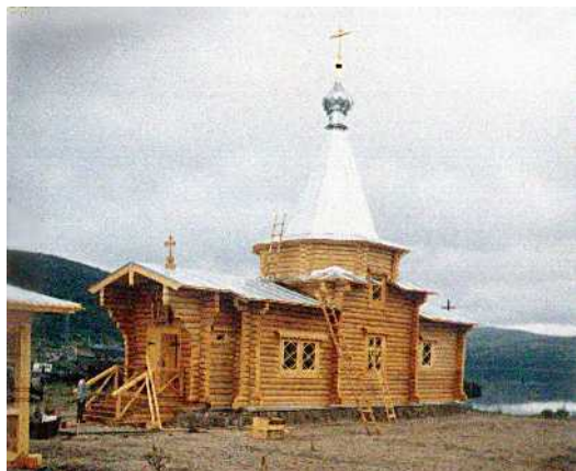
Завершение строительства Никольской полковой церкви. Ара-губа близ пос. Видяево. Фото около 2000 г.
