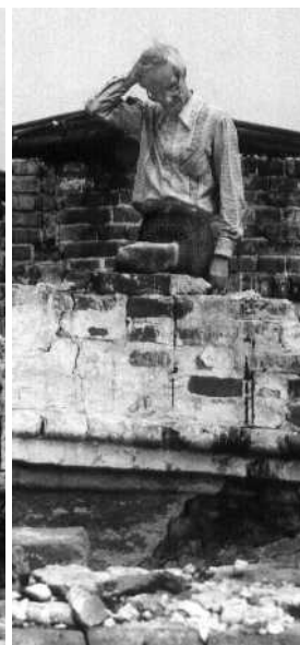
Л. С. Васильев на кровле церкви Вознесения на Дебре. Ок. 1987 г.
