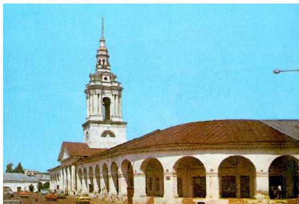
Красные ряды с колокольней церкви Спаса. Реконструкция на сер. 1970-х гг. по фото начала 1980-х гг.
