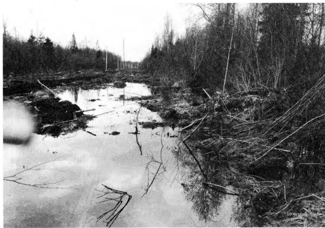
Илл. 39. Точка 6-596. Вид на трассу ЛЭП в районе железобетонной опоры 63 на юг.
