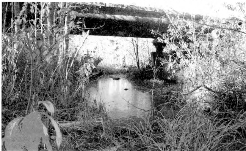
Илл. 34. Точка 2-639. Мост через р. Витальевку. Вид с востока. Фото А. В. Белова.
