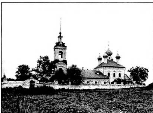
Никольская церковь. Фото 1976 г.
