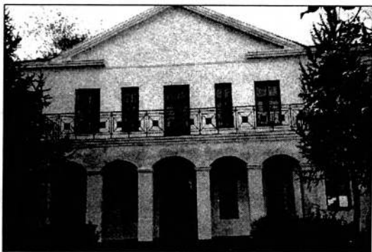
Контора. Фото 1999 г.
