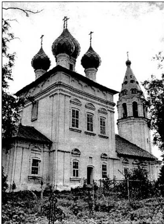
Никольская церковь. Фото 1976 г.
