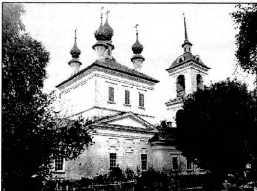
Троицкая церковь. Фото 1976 г.
