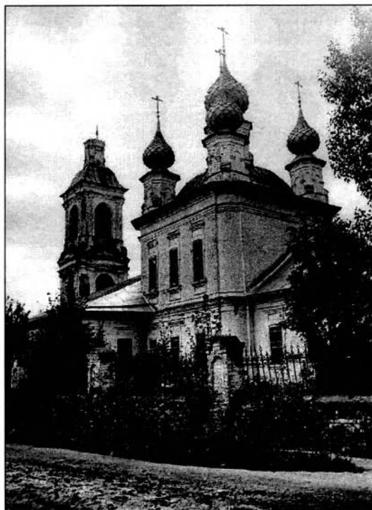
Троицкая церковь. Фото 1976 г.
