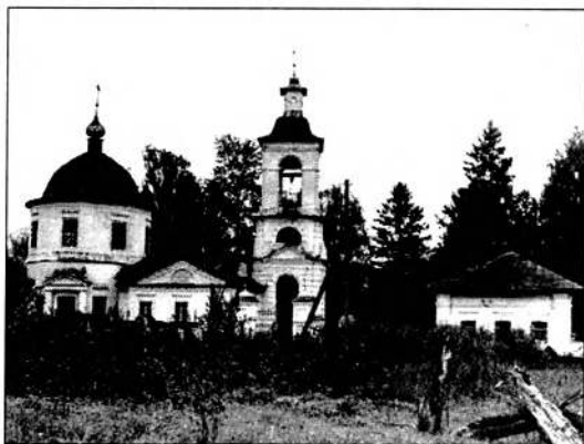
Никольская церковь. Фото 1973 г.
