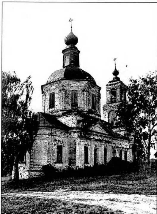
Никольская церковь. Фото 1999 г.
