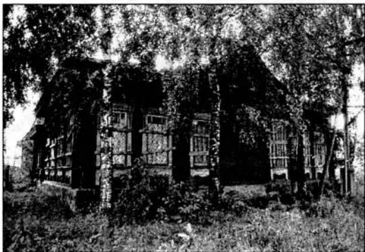
Общественное здание. Фото 1998 г.
