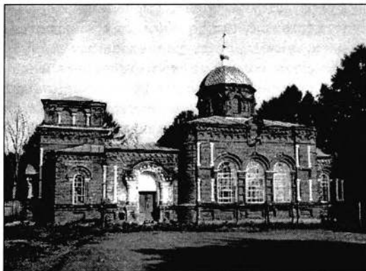
Никольская церковь. Фото 1999 г.
