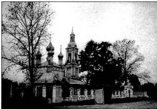
Никольская церковь. Фото 1998 г.
