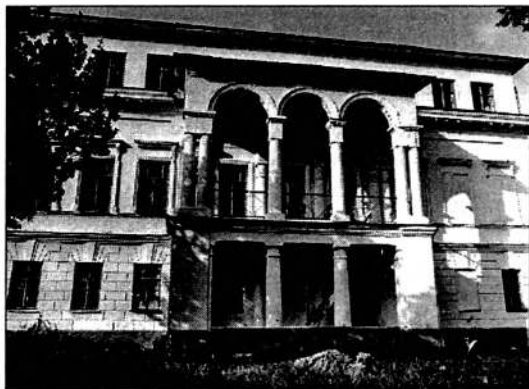
Главный дом. Южный фасад. Фото 1976 г.
