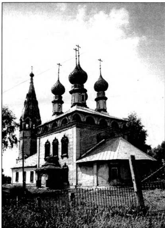
Никольская церковь. Фото 1999 г.
