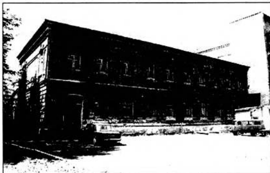
Производственный корпус. Фото 1999 г.
